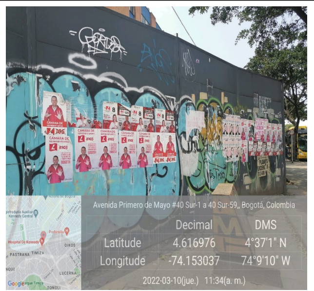
Elementos tipo AFICHES instalados en muro de cerramiento.
